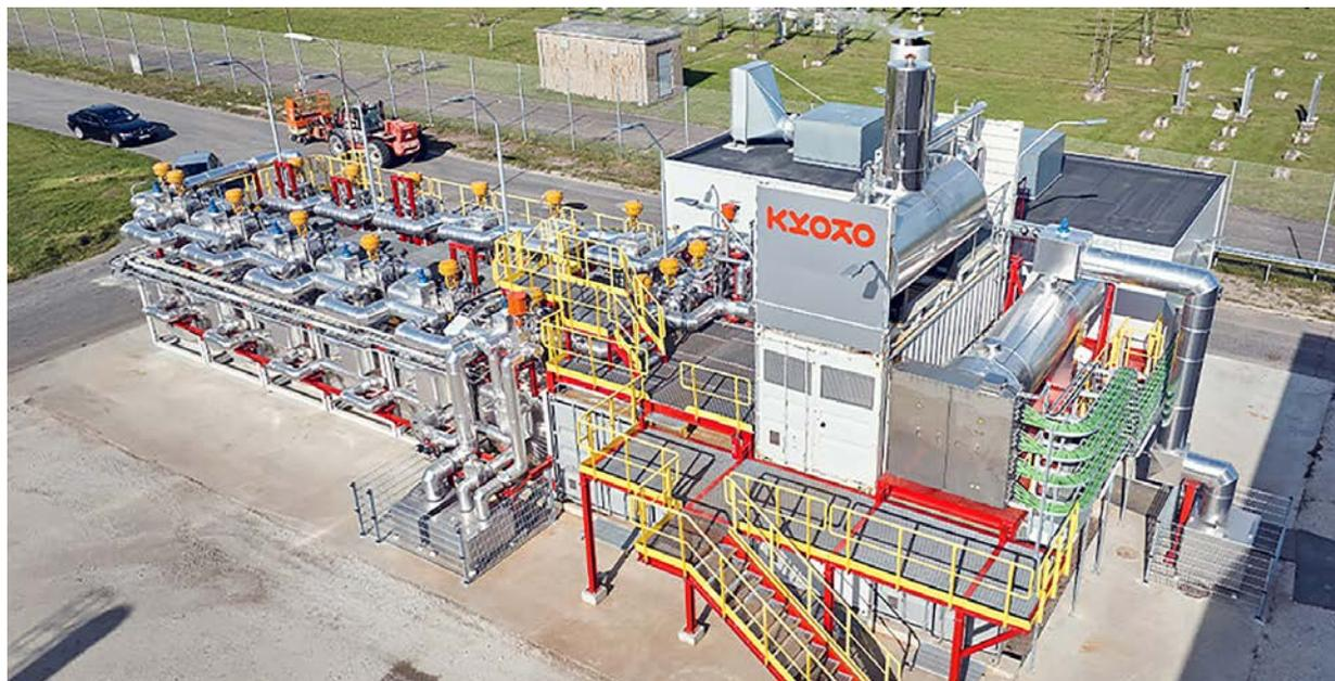
**Abb. 3:** Der Norbis Park Heatcube im dänischen Aalborg ersetzt Kohle als Energieträger für die Erzeugung von Fernwärme. Die Anlage hat eine Ladekapazität von 5 MW und eine Speicherkapazität von 18 MWh. Dieser Heatcube senkt die CO<sub>2</sub>-Emissionen um bis zu 2.000 Tonnen pro Jahr.
