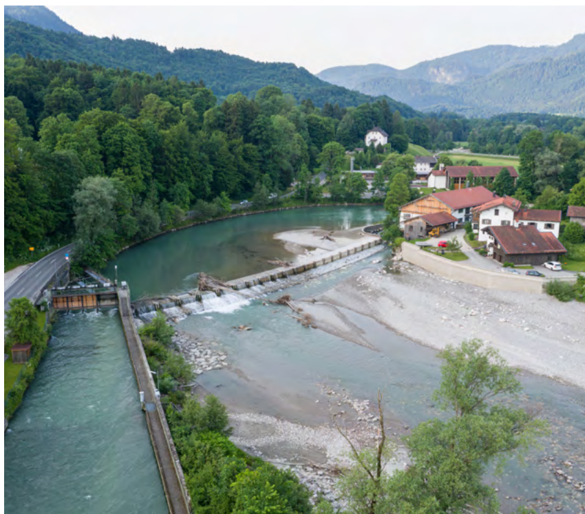
Ableitungskanal für Kraftwerk Gränzmühle an der Tiroler Achen bei Marquartstein, nahe dem Chiemsee
